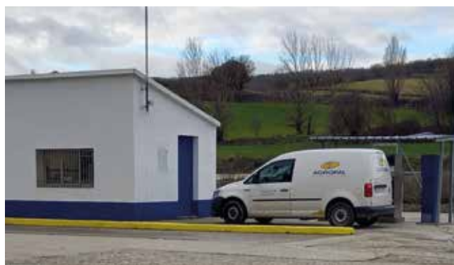
Nuevo almacén en Castrillo de Don Juan
